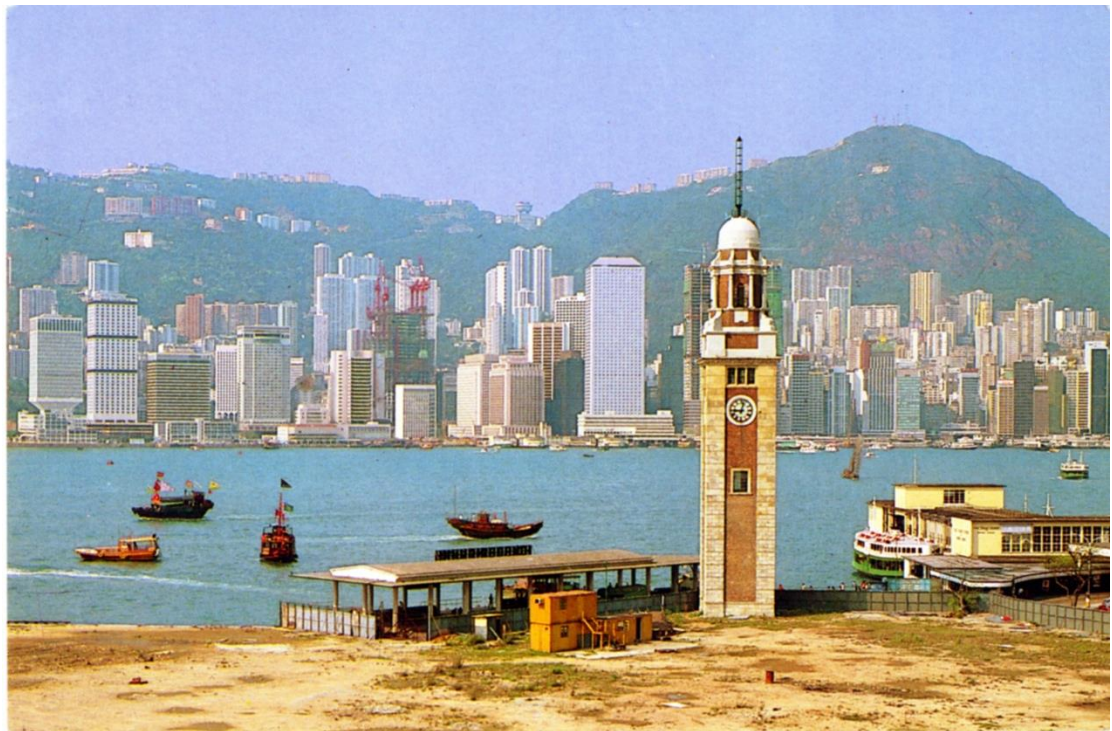
舊尖沙咀火車站拆卸後，香港文化中心尚未建成，尖沙咀鐘樓孤伶伶聳立在尖沙咀海濱。維港對岸可見第四代香港匯豐銀行大廈正在興建。(蔡思行藏)
