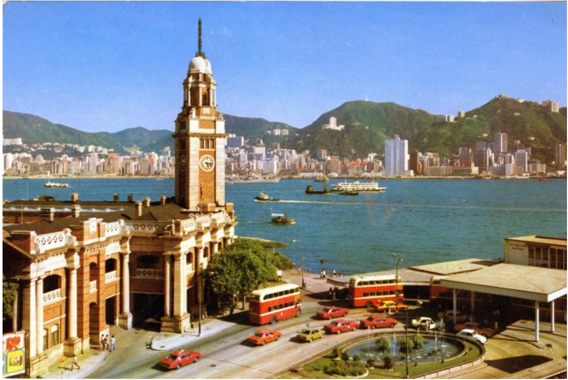
未拆卸前的尖沙咀火車站，可見鐘樓為火車站的組成部分，成為戰後香港明信片主要取景的對象之一。(蔡思行藏)
