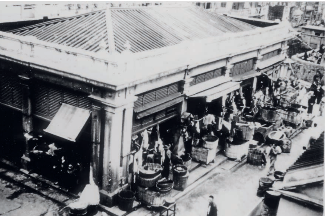
圖 1.20 石塘咀街市的四個角落均採用兩條柱子支撐。 (P1973.411, n.d., photograph, Hong Kong History Museum.)
