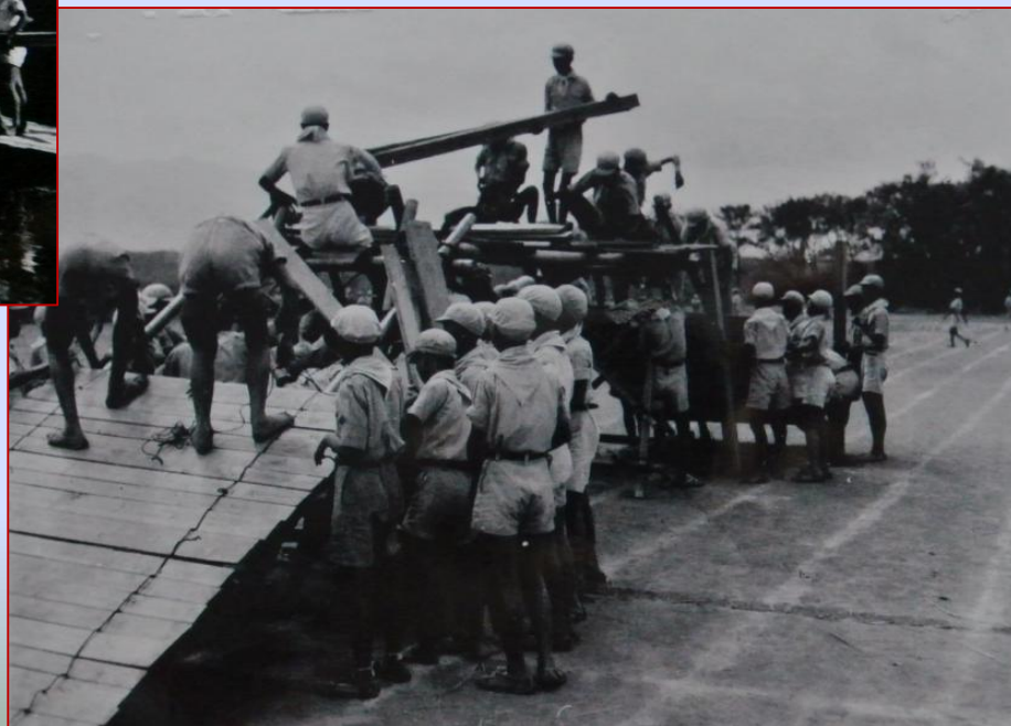
搭建陸路行軍高架橋
